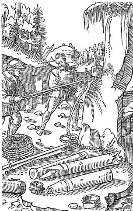
Georgius Agricola, De Re Metallica , 1556. Mesure d'une corde à l'aide d'une jauge de référence fixe.
